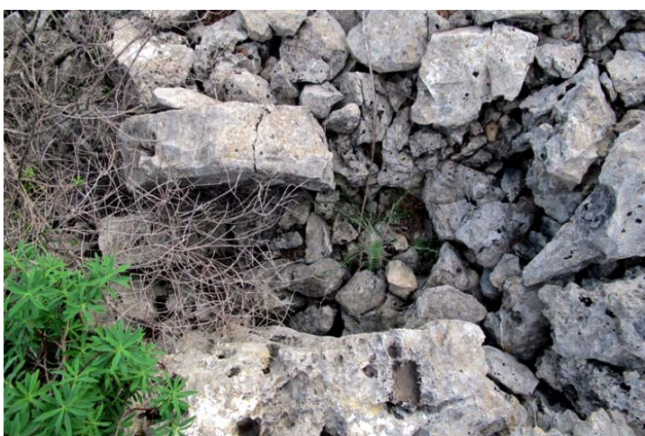
Ninxol obert al parament del mur exterior.
