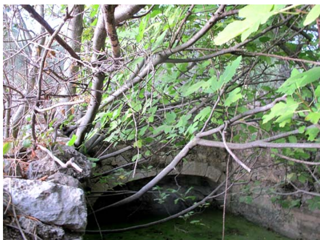
Detall de l'interior (parets Nord i Est) amb un arc en pedra seca i les parets enlluïdes.
