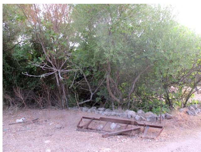
Vista exterior del safareig, totalment cobert de vegetació.
