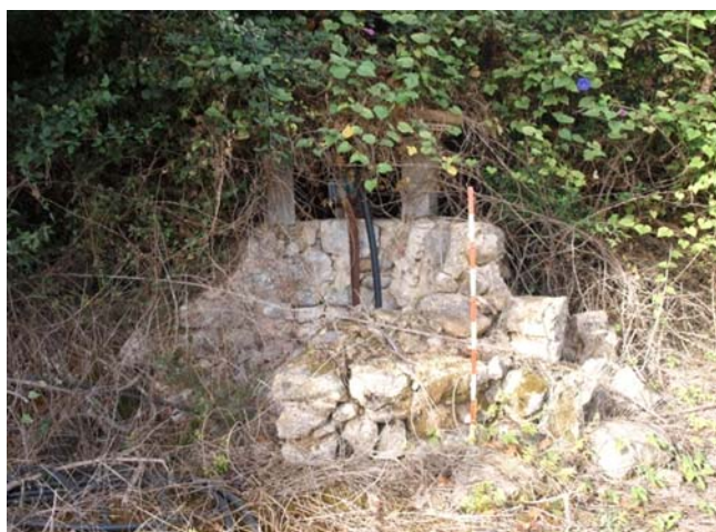
Vista general i de detall del pou amb dos mànegues per extreure aigua.
