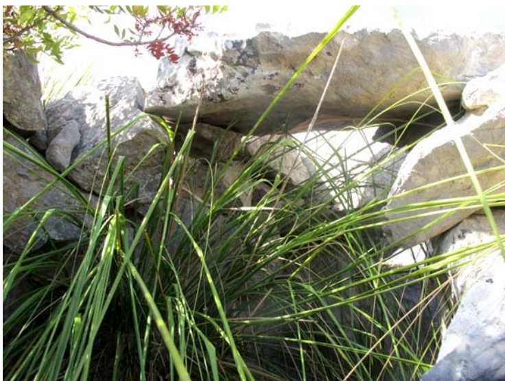
Detall de la llinda sobre el mur Sud.
