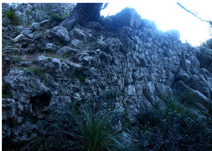
Perforacions practicades a la roca, molt possiblement per a la captació d'aigua pluvial per filtració.
