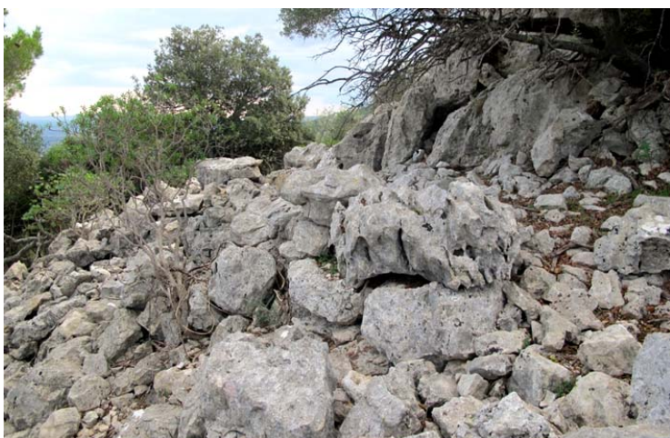
Restes de murs molt deteriorats.
