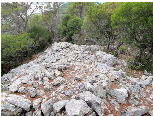
Vista del doble parament i la cara interna del mur Sud.
