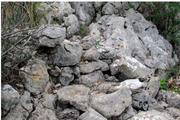
Parament d'un dels murs.
