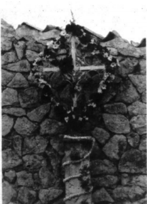
Estat abans de la reforma
