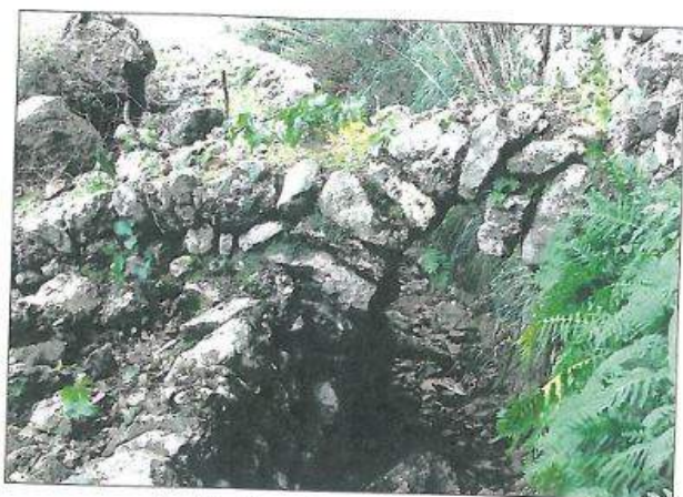
Pontet al torrent de sa Coveta Negra
